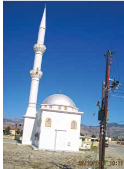
Düzova Köyü Camii-Lefkoşa
