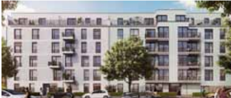
Neubau: Schulzstraße - Pankow Berlin 2020
