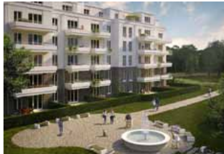
Neubau: Brunnenviertel - Potsdam 2019
