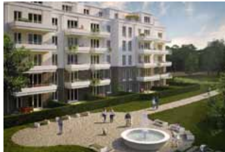
Neubau: Brunnenviertel - Potsdam 2019
