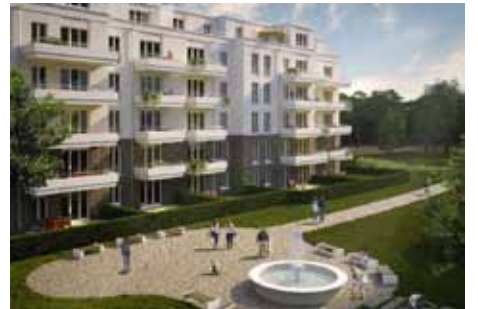
Neubau: Brunnenviertel - Potsdam 2019
