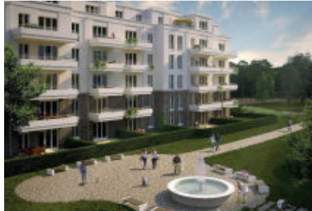
Neubau: Brunnenviertel - Potsdam 2019
