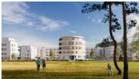
Neubau: Wohnen am Turm - Lichterfelde Berlin 2020
