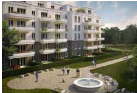
Neubau: Brunnenviertel - Potsdam 2019
