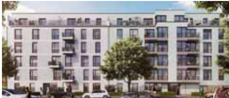
Neubau: Schulze Straße - Pankow Berlin 2020
