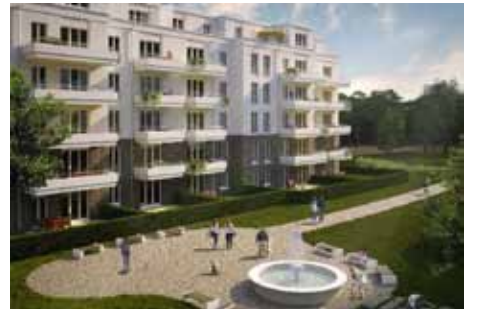
Neubau: Brunnenviertel - Potsdam 2019
