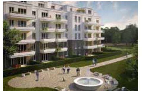
Neubau: Brunnenviertel - Potsdam 2019
