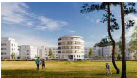
Neubau: Wohnen am Turm - Lichterfelde Berlin 2020
