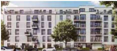
Neubau: Schulze Straße - Pankow Berlin 2020
