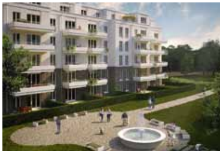
Neubau: Brunnenviertel - Potsdam 2019
