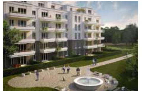
Neubau: Brunnenviertel - Potsdam 2019
