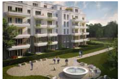
Neubau: Brunnenviertel - Potsdam 2019
