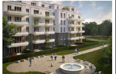
Neubau: Brunnenviertel - Potsdam 2019
