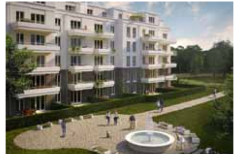
Neubau: Brunnenviertel - Potsdam 2019
