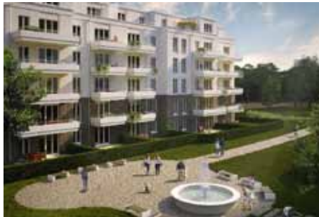
Neubau: Brunnenviertel - Potsdam 2019
