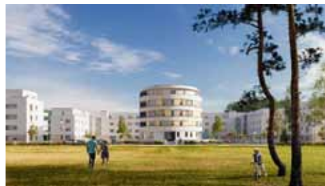
Neubau: Wohnen am Turm - Lichterfelde Berlin 2020
