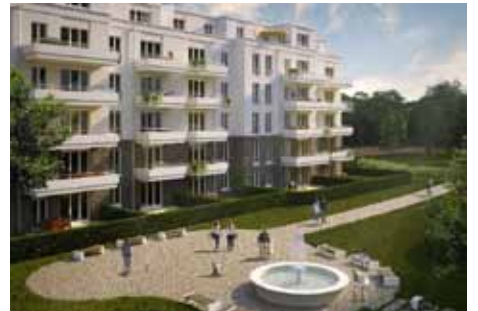
Neubau: Brunnenviertel - Potsdam 2019
