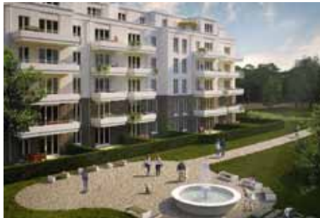
Neubau: Brunnenviertel - Potsdam 2019
