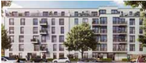
Neubau: Schulze Straße - Pankow Berlin 2020
