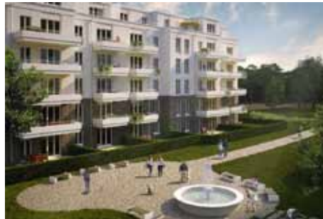
Neubau: Brunnenviertel - Potsdam 2019
