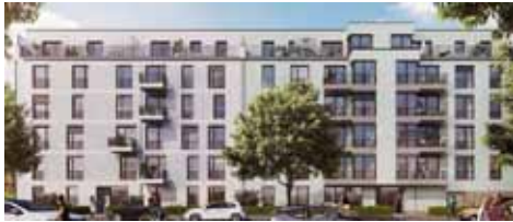
Neubau: Schulze Straße - Pankow Berlin 2020
