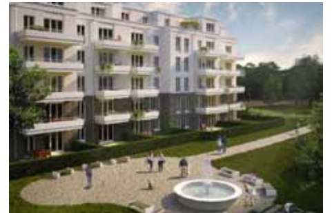
Neubau: Brunnenviertel - Potsdam 2019
