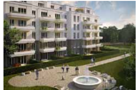
Neubau: Brunnenviertel - Potsdam 2019
