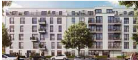
Neubau: Schulzstraße - Pankow Berlin 2020
