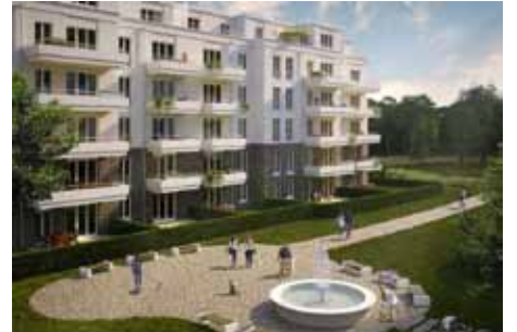
Neubau: Brunnenviertel - Potsdam 2019
