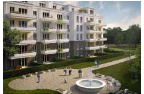
Neubau: Brunnenviertel - Potsdam 2019
