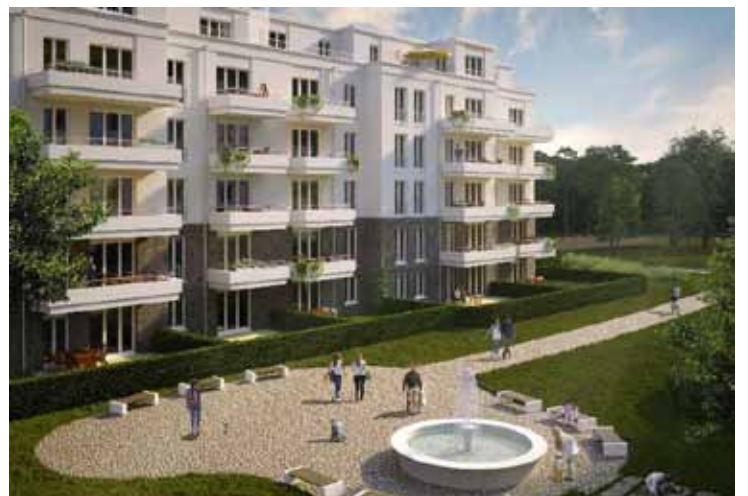
Neubau: Brunnenviertel - Potsdam 2019
