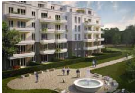
Neubau: Brunnenviertel - Potsdam 2019
