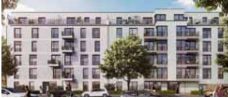
Neubau: Schulzstraße - Pankow Berlin 2020
