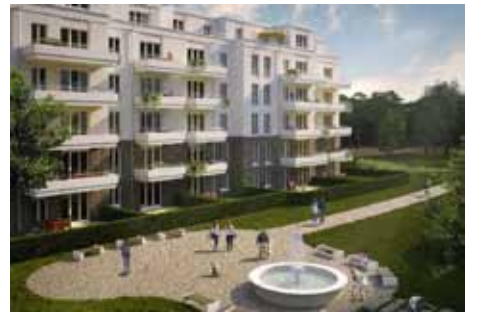
Neubau: Brunnenviertel - Potsdam 2019
