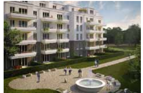
Neubau: Brunnenviertel - Potsdam 2019
