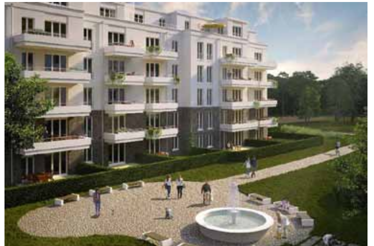
Neubau: Brunnenviertel - Potsdam 2019
