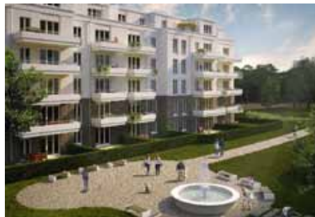
Neubau: Brunnenviertel - Potsdam 2019
