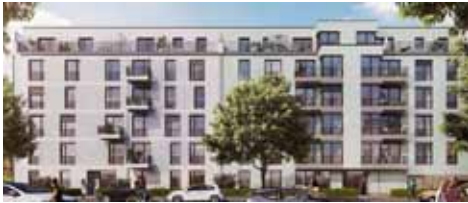
Neubau: Schulzstraße - Pankow Berlin 2020
