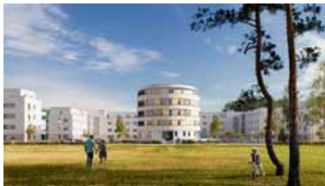
Neubau: Wohnen am Turm - Lichterfelde Berlin 2020
