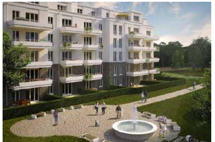
Neubau: Brunnenviertel - Potsdam 2019
