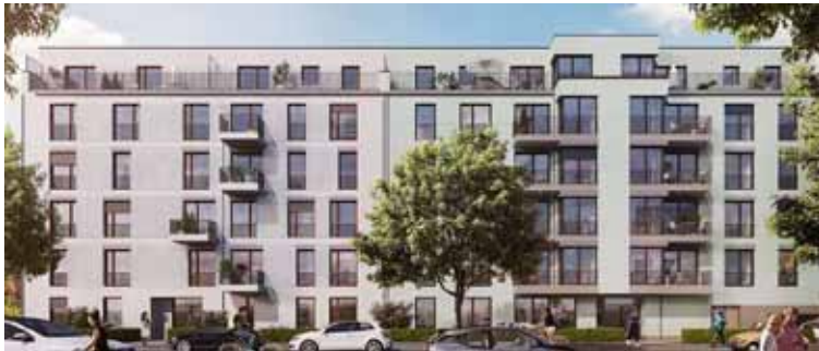
Neubau: Schulze Straße - Pankow Berlin 2020
