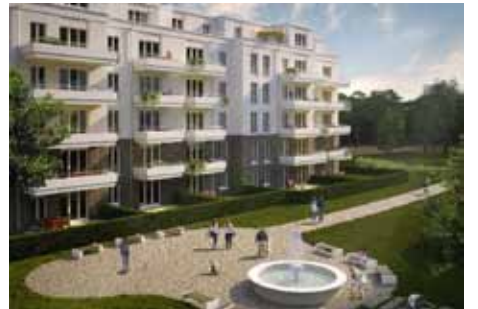
Neubau: Brunnenviertel - Potsdam 2019
