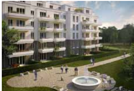
Neubau: Brunnenviertel - Potsdam 2019
